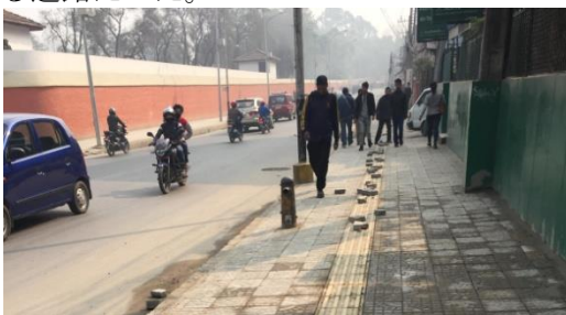
貼ったばかりの点字ブロックの完成まで 重しを載せた道路
