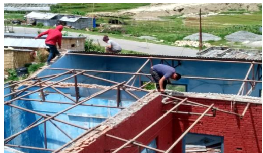
職業訓練所の2階部分の解体工事
