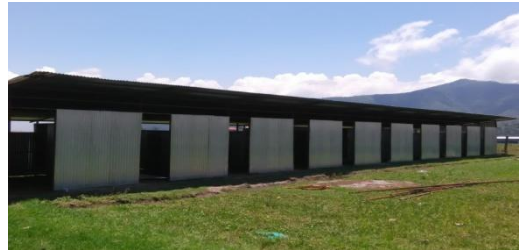
10 教室分の仮校舎
