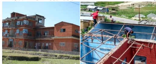
震災前の職業訓練所と震災後の解体作業
