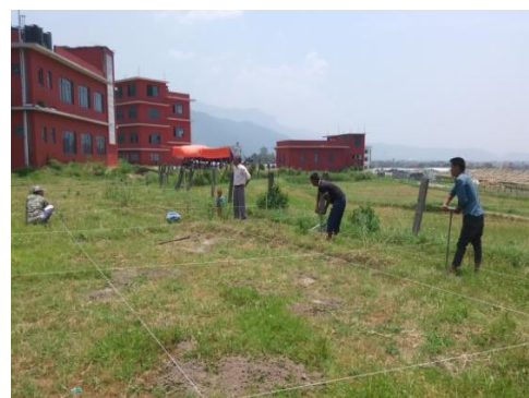
校庭で仮設校舎建設の準備
