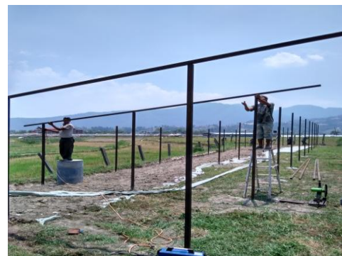
仮設校舎建設中
